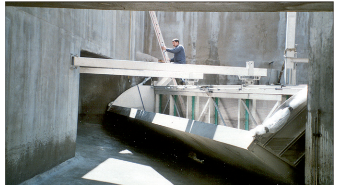
ARA Telli in Aarau, ROMAG-Siebrechen RSW-K 14x8/4 (Einbauphase)
