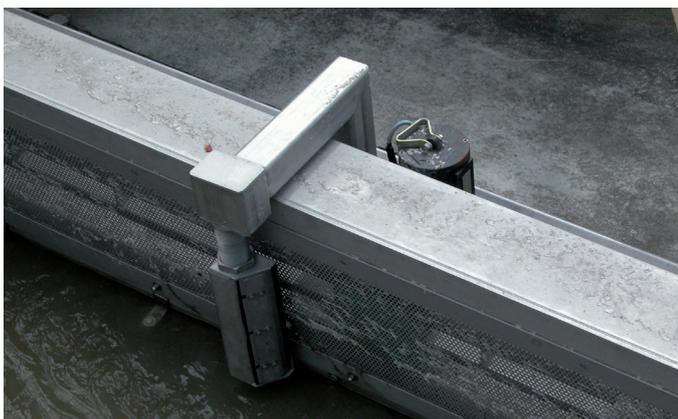
Siebanlage RSL, Zulaufseite (2Modul hoch)
