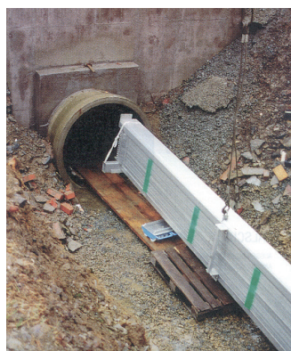
Introduzione della griglia attraverso la condotta di scarico.
