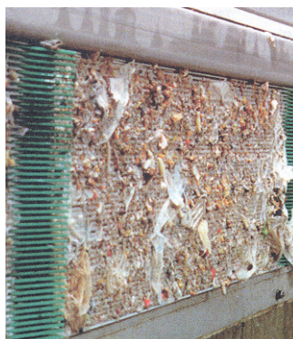
Alternativa, rifiuti nella griglia (con movimento del pettine disattivato)
