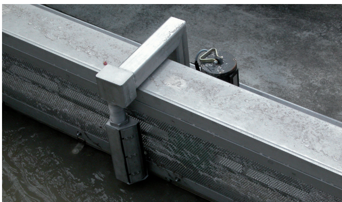
Tamis RSL, côté admission (Module 2 haut)
