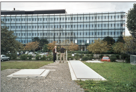
Neuhof Baar: Hochwasserentlastung und Speicherkanal; Begehbare Zugangsabdeckungen mit Klappgeländer (kleiner Deckel links).
