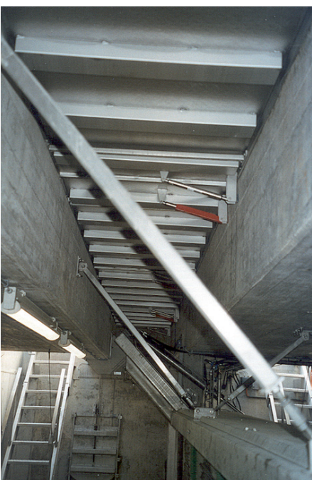
Neuhof Baar: Hochwasserentlastung und Speicherkanal; Begehbare Zugangsabdeckungen mit Klappgeländer (kleiner Deckel links).
