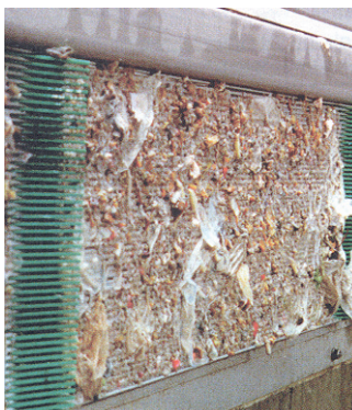
.....ou dans la STEP (déchets dans le dégrilleurs sans mouvement de nettoyage)
