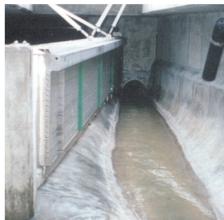
Dégrilleur RSW 5x7/4 sur le trop-plein d'un bassin fermé
