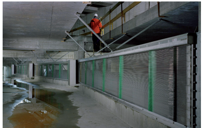
Montage de 3 dégrilleurs dans l'affluent de la STEP Aire à Genève
