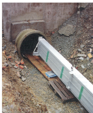
Mise en place d'un dégrilleur par la conduite de décharge
